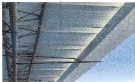
Foto 8: 7.2 Sustitución de canal de PVC en modulo 2
