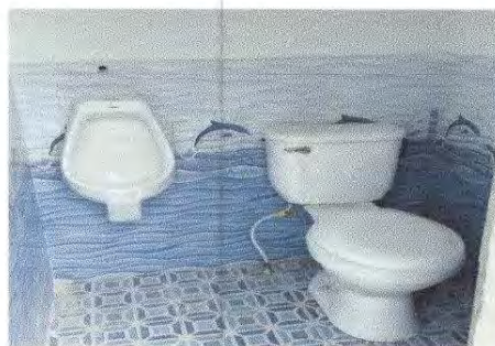
Foto 10: 10.3 Sustitución de inodoro de servicio sanitarios para niños
