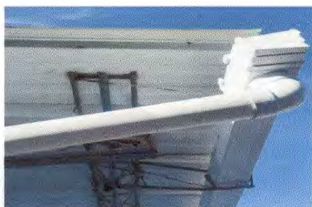
Foto 9 :7.4 Sustitución de bajada de agua pluvial de metal por tubo PVC 3" modulo 2
