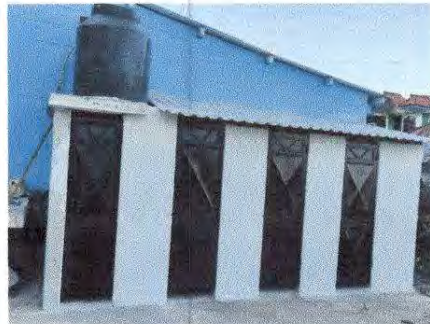
Foto 2: 4.3 Sustitución de Puerta en sanitarios
