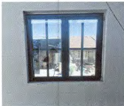
Foto 4: 5.3 Sustitución de ventana en cocina
