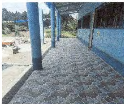
Foto7: 6.7 Sustitución de piso de granito en corredor modulo 1
