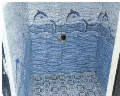
Foto 13: 13.1 Sustitución de azulejo para lavamanos
