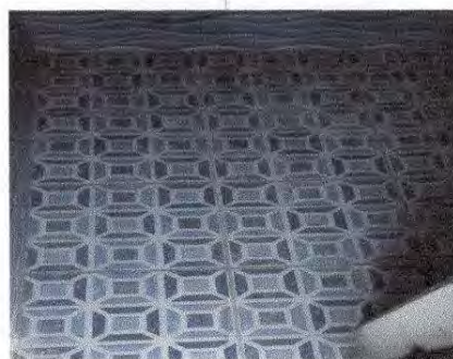
Foto 6: 6.6 Sustitución de piso líquido en sanitarios
