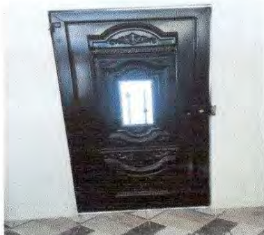
Foto 3: 4.3 Sustitución de Puerta en cocina
